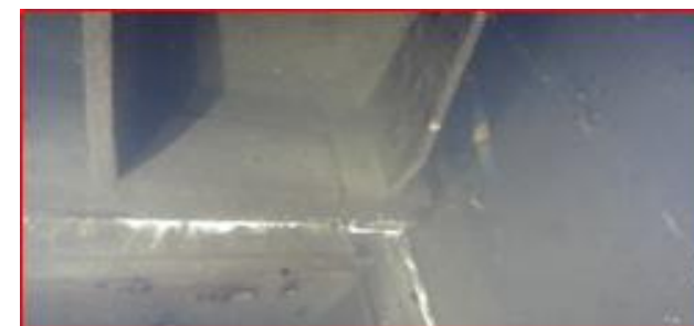
Ispezione stato di conservazione organi intercettazione idraulica
