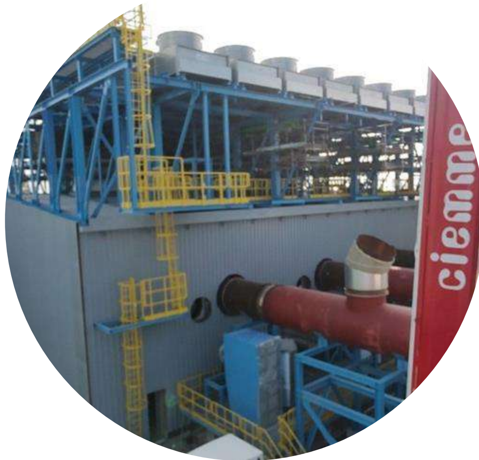
Completamento pannellatura edificio motori A
